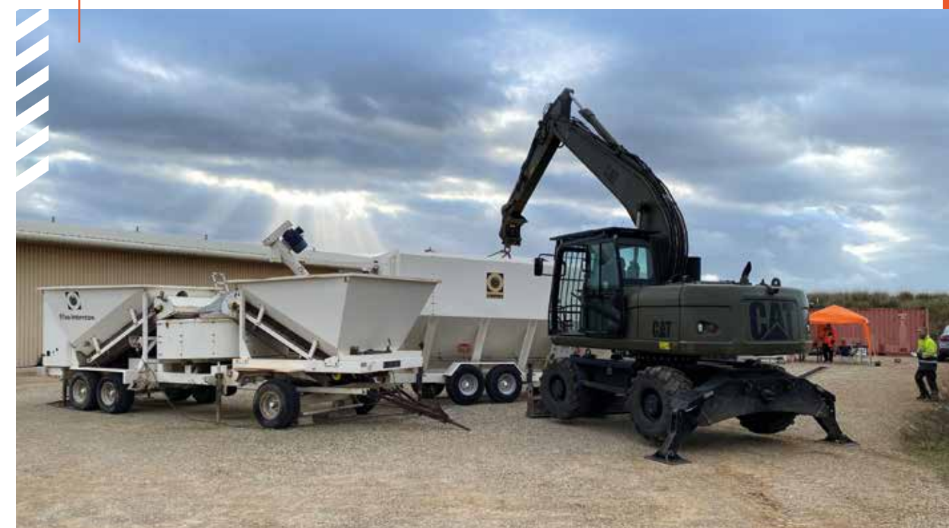
Fabrication de béton dans les bases militaires
