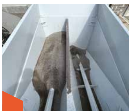
8 Réhausse de trémies périmétriques
